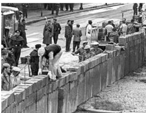
Bau der Berliner Mauer (commons.wikimedia.org)
